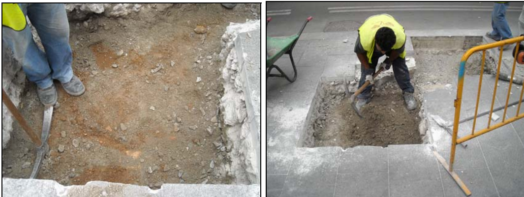
Cala 2 durant el procés de rebaix.
