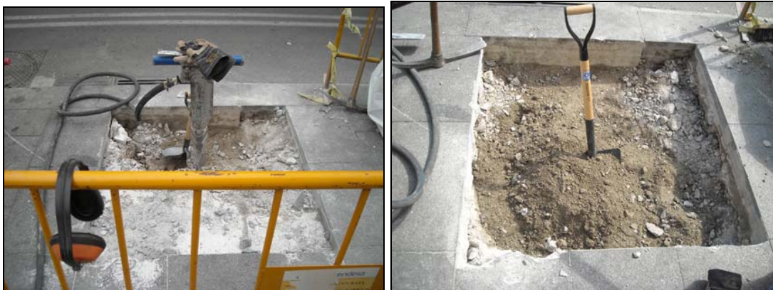
Fotos cala 1 durant el procés de rebaix.
